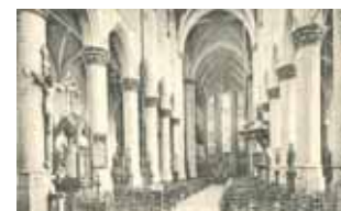
Interno della chiesa
